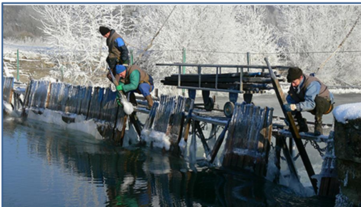
Illustration 1-022 : un barrage à aiguilles manœuvré ... au XXI ème siècle ! [VNF-DTNE]
