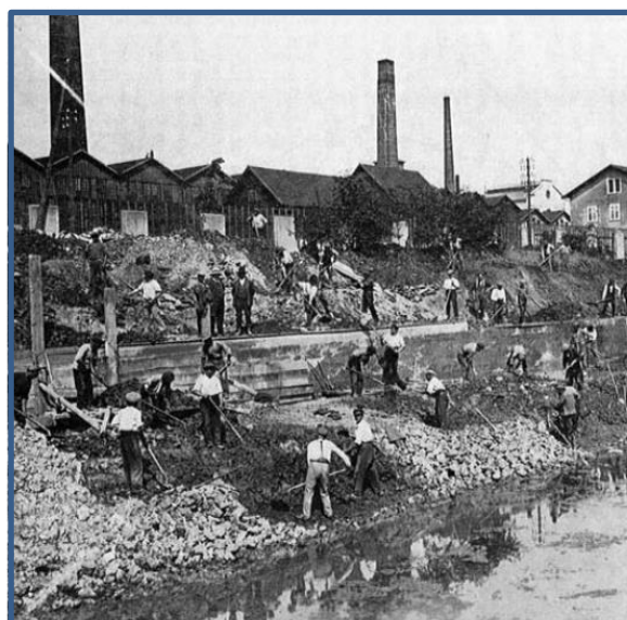
Réfection de berge
