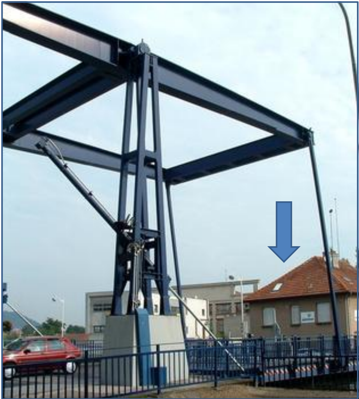
Illustration 6-056 : le bâtiment du SHOMM à Nancy [Structurae]
