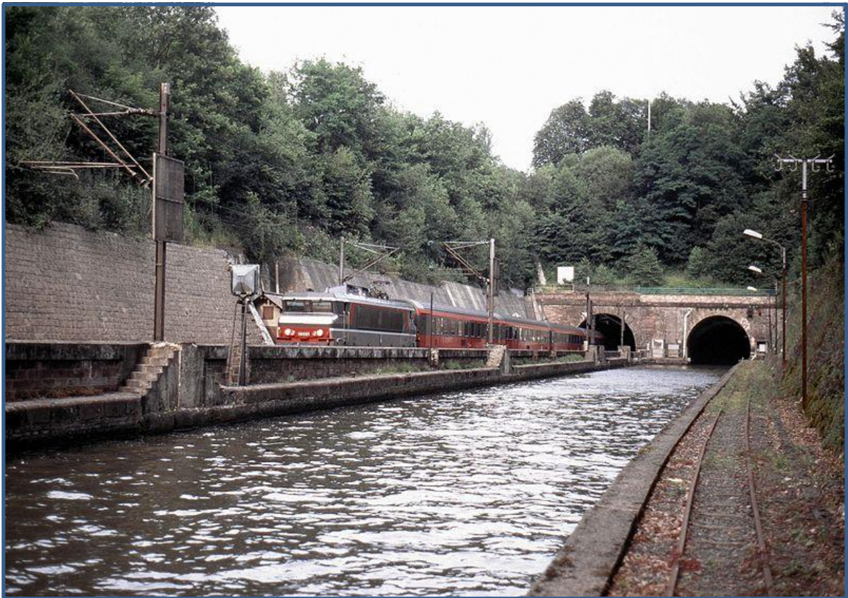
Illustration 2-001 : tunnels fluvial et ferroviaire accolés sur le canal de la Marne au Rhin à Arzwiller (à noter aussi les rails du halage en rive droite) [Wikipédia]
