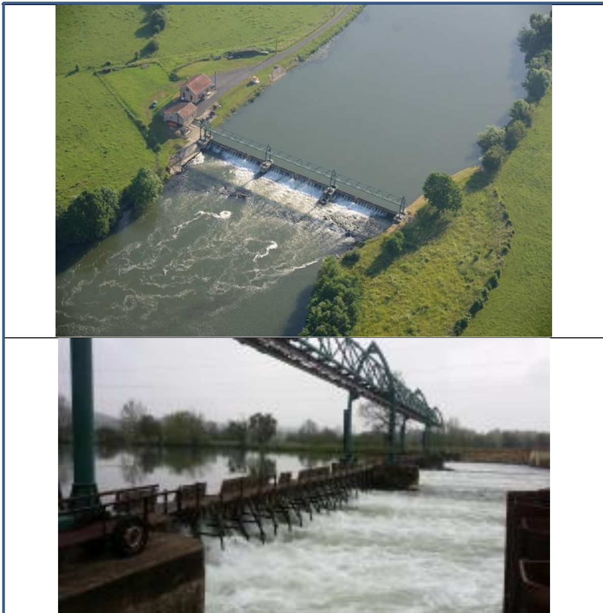
Illustration 6-024 : la poutre d'assurage du barrage de Romery [Internet]
