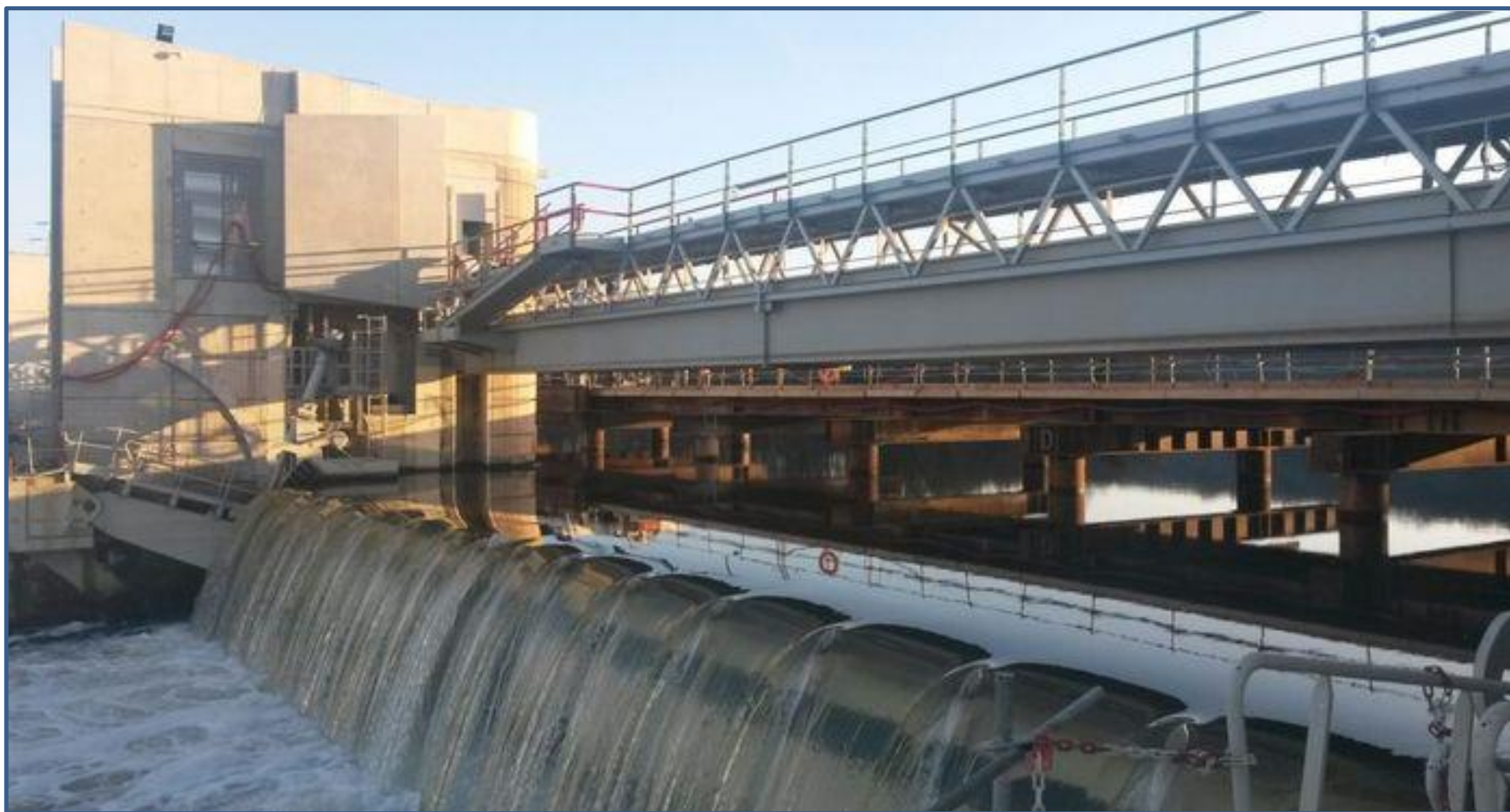
Illustration 6-040a : les nouvelles bouchures « segment + clapet » du barrage du Liégeot [scmf.eu]
