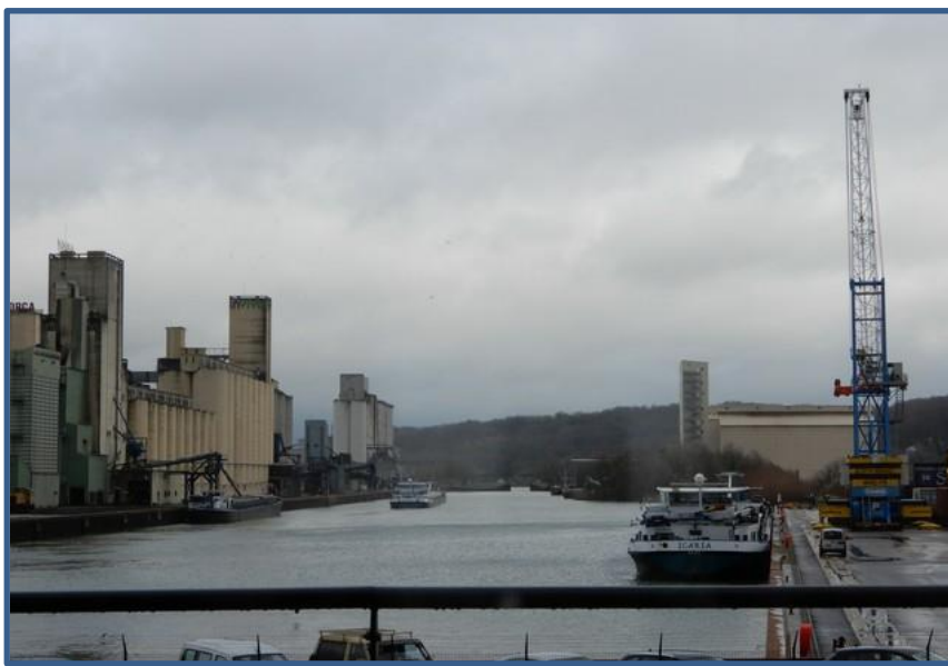
Illustration 6-035 : le nouveau port de Metz (les silos céréaliers à gauche et la future plate-forme conteneurs à droite) [CFDT]
