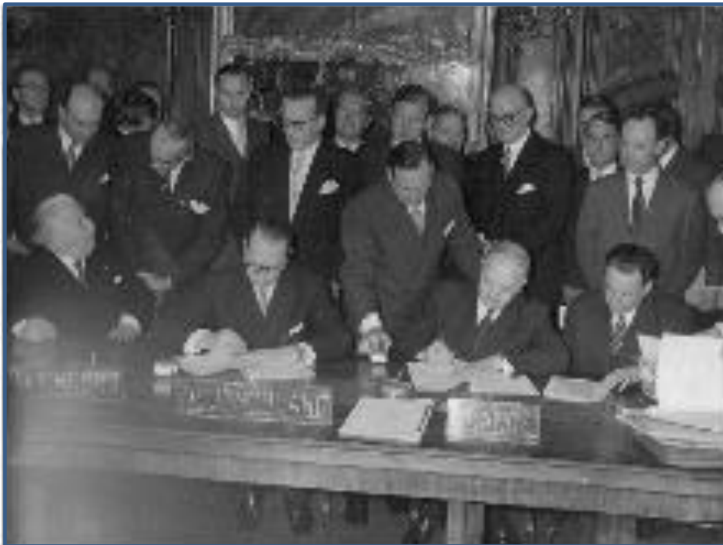
Illustration 5-004 : signature des traités pour la canalisation de la Moselle à grand gabarit [CIM]
