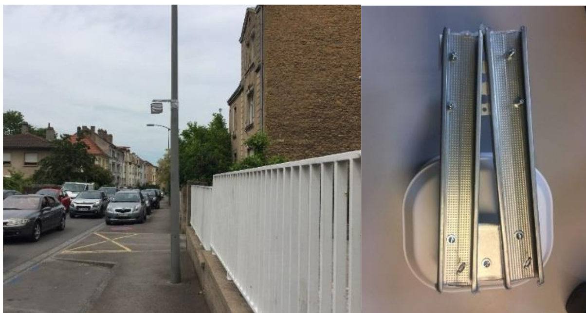
Figure 132 : À gauche station météorologique du réseau REMTHAM (rue de Saint-Paul, Montigny-lès-Metz). À droite : système de fixation de l'abri.
