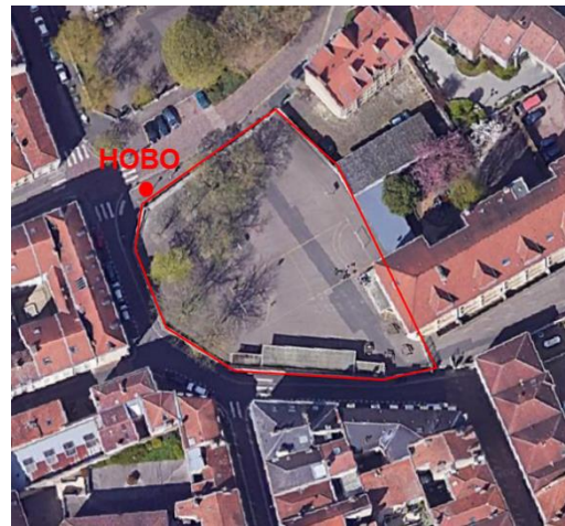
Figure 91 : Vue aérienne de la cour de l'école Saint-Eucaire avant travaux (Source : Google Earth).
