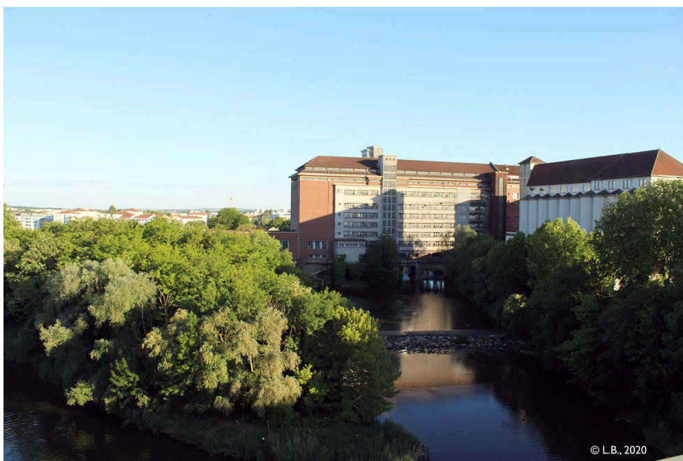
Photo 3 : vue vers le Sud du bâtiment-pont des Grands Moulins (crédits : Léopold Barbier, 2020)
