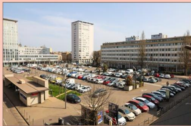
Le parking de la place Coislin sera bientôt désimperméabilisé aussi. Photo archives RL/Gilles WIRTZ
