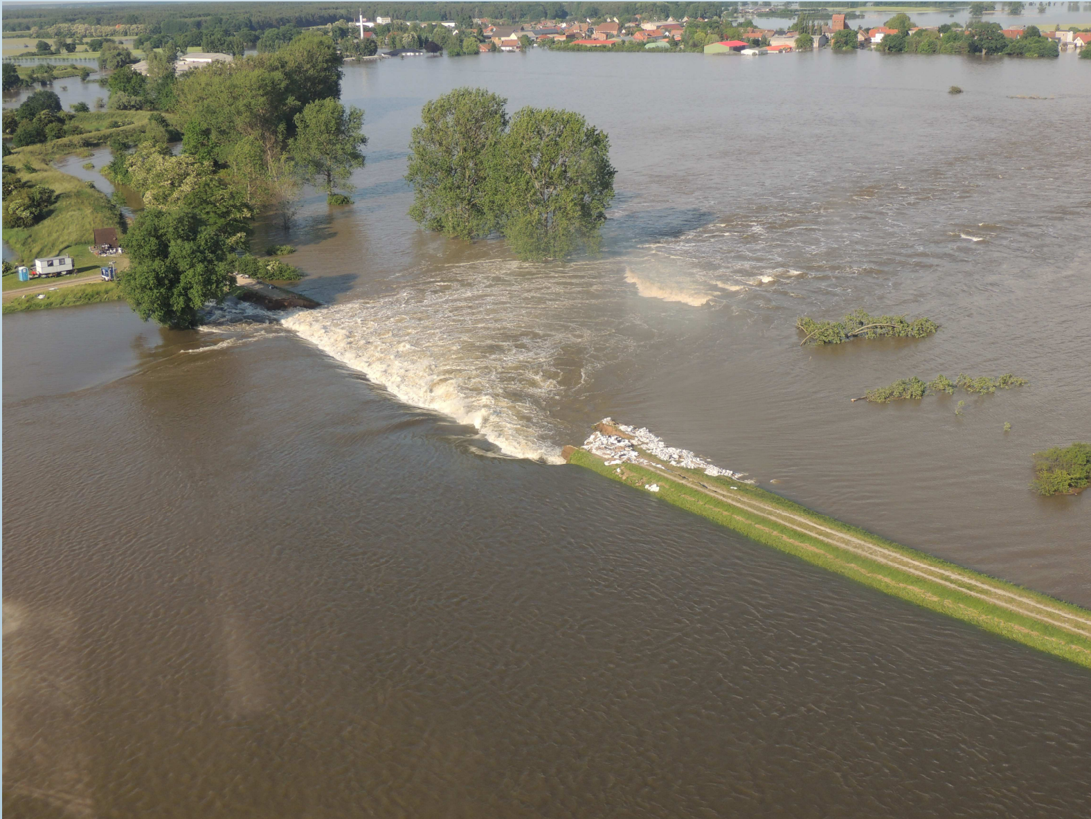
Deichbruchstelle bei Fischbeck an der Elbe am 10. Juni 2013 (Foto: Jüpner, 2013)
